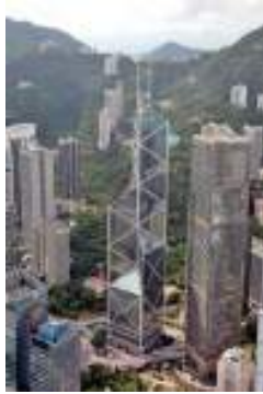
بانک برج چین که در هنگ کنگ، چین، توسط I.M. Pei طراحی و توسط همکاران زلزلی ای. رابرتسون مهندسی شده است، در سال ۱۹۹۰ به پایان رسید. از ساختار و خطوط سیستم مهاربندی قطری برای تقویت تغییرات در شکل ساختمان استفاده شده است.
