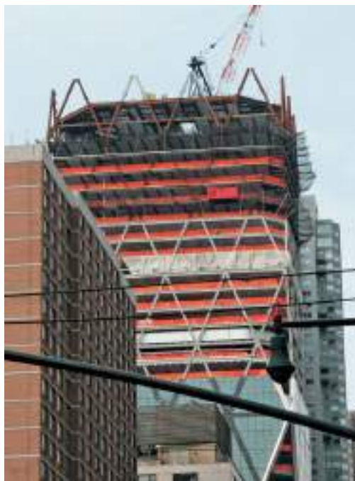
مراحل نصب و اجرای پوشش ضد حریق در حال ساخت بنا
