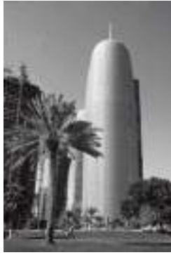
۲۰۱۲ برج الدوحه - ارتفاع ۲۳۸ متر: نوع سیستم : پنهان و آی.اس.اس Terrell Group, China Construction
