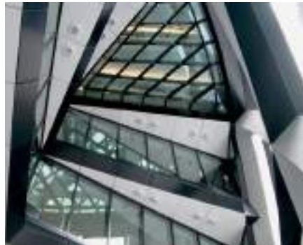
دیاگرید از دیوار پرده ای جدا شده تا یک ردیف ستون در پایه ی بنا ایجاد کند.
