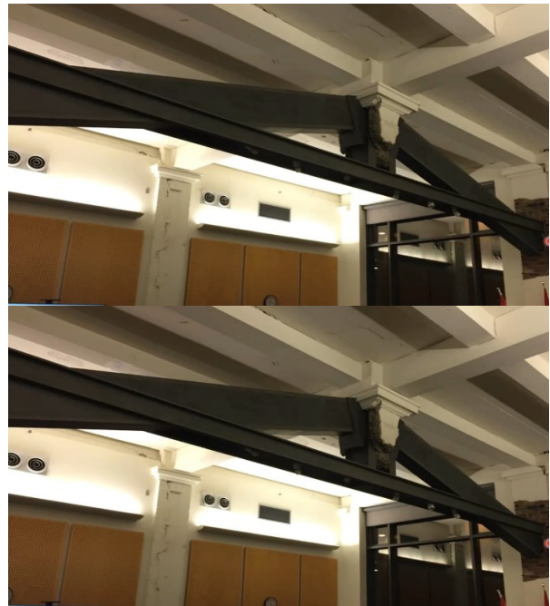
شکل ۱- شمع‌بندی و استفاده از پروفیل‌ها به روشی خاص برای جلوگیری از انهدام پیش‌رونده‌ی ناشی از برداشتن ستون به علت ملاحظات معماری
