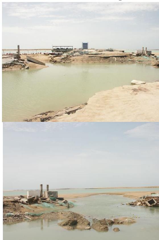
شکل ۵- تخریب اسکله صیادی تنگ در اثر طغیان رودخانه گروک و در محل اسپیت تنگ همزمان با طوفان حاره ای گونو در سال ۱۳۸۶ (منبع نگارنده)
