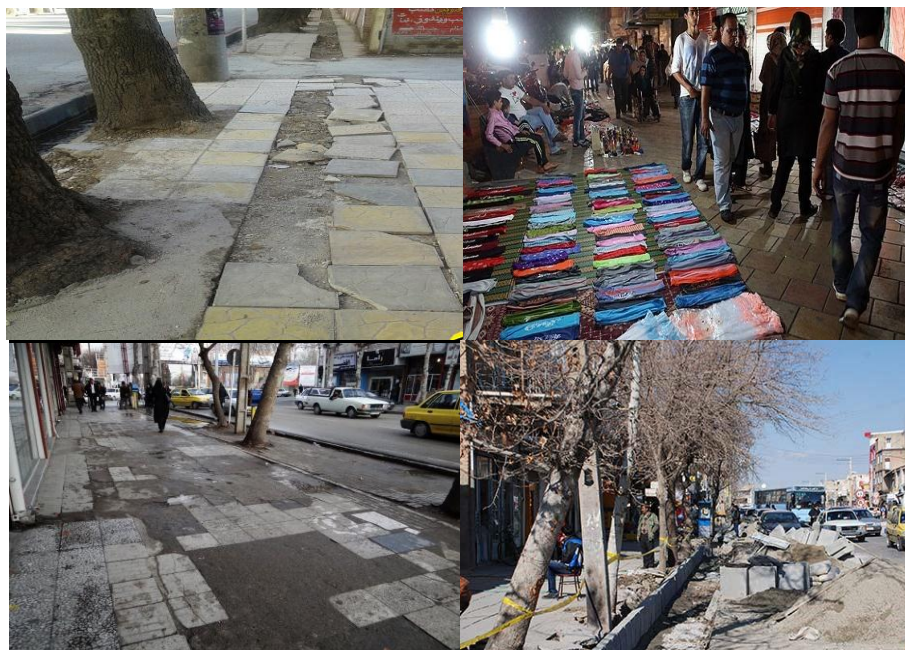
شکل ۳. برخی از مشکلات و چالش‌های موجود در مسیرهای پیاده
