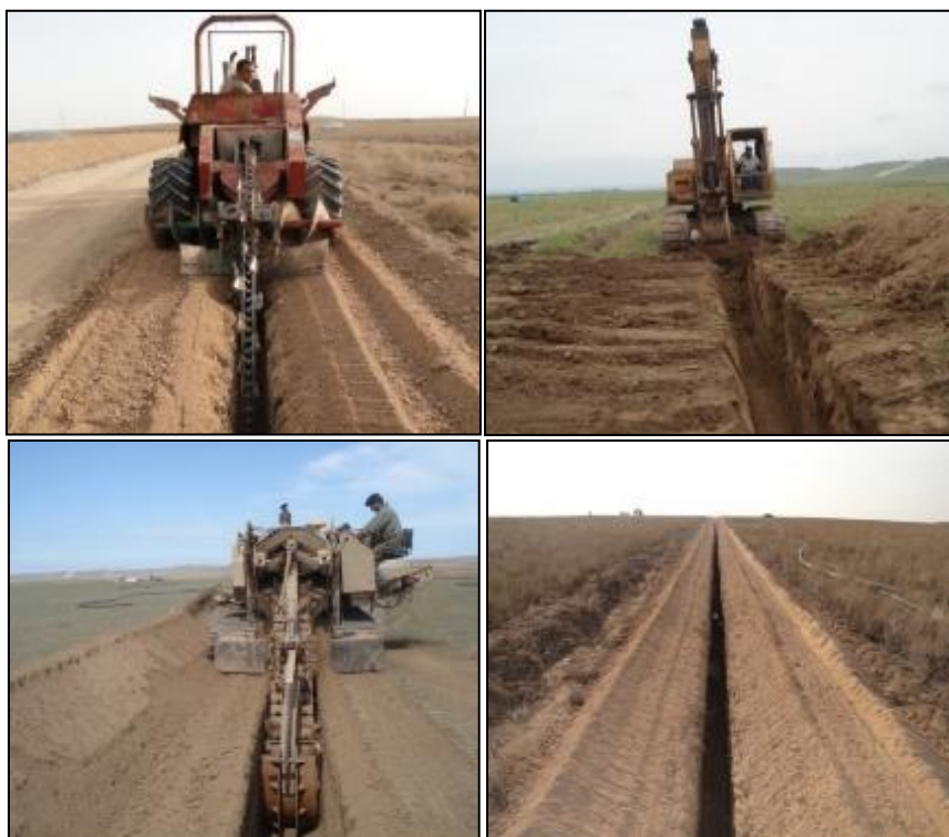
شکل ۶-۱۴- حفاری ترانشه مسیر خط لوله با بیل مکانیکی و ترنچر
