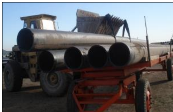
شکل ۶-۲- حمل لوله‌های پلی‌اتیلن به وسیله تریلی
