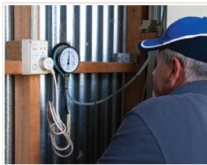
شکل ۸-۱۲- بررسی فشار کارکرد پمپ
