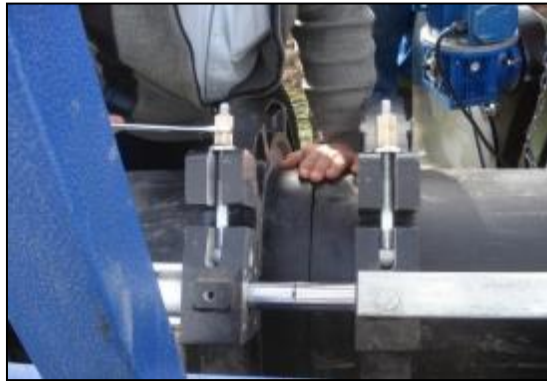
شکل ۶-۸- تنظیم و تراز کردن دو سر لوله‌های پلی‌اتیلن
