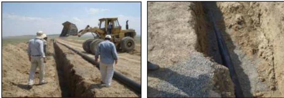
شکل ۶-۱۸- شنریزی دور لوله‌های پلی‌اتیلن
