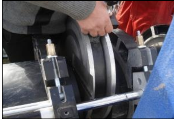
شکل ۶-۷- رنده‌کاری لبه لوله‌های پلی‌اتیلن
