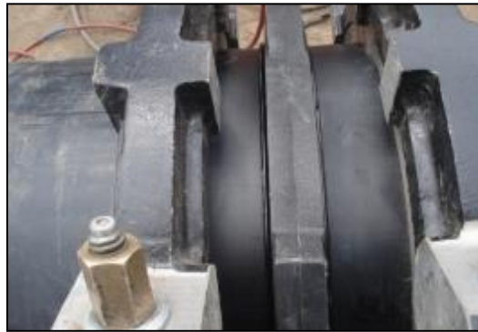
شکل ۶-۹- قرارگیری اتو بین دو سر لوله
