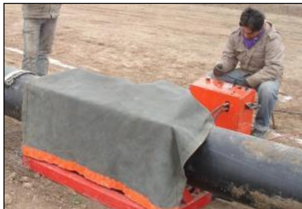
شکل ۴-۶- جوشکاری با نیروی محرکه ژنراتور در شرایط نامناسب جوی
