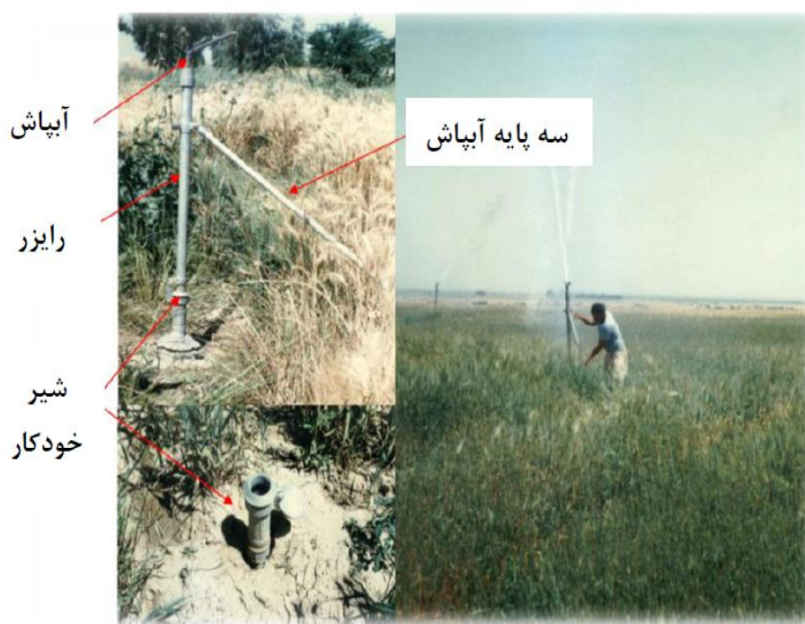
شکل ۸-۲۹- اتصالات و تجهیزات سیستم آبیاری بارانی کلاسیک ثابت با آبپاش متحرک
