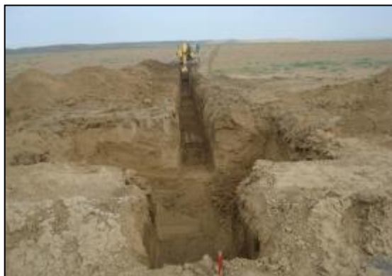
شکل ۶-۱۵- حفاری محل احداث حوضچه شیرآلات
