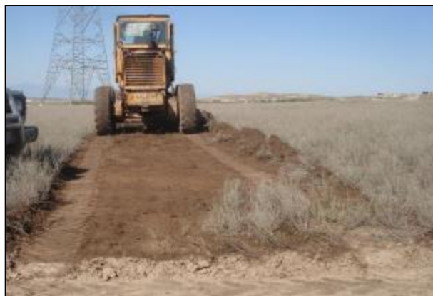
شکل ۶-۱- دکوپاژ (برداشت خاک نباتی) مسیر خط لوله
