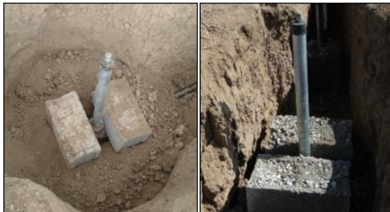
شکل ۶-۱۶- قرار دادن شیر قطع و وصل جریان در ابتدای خطوط مانیفولد
