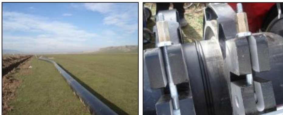
شکل ۶-۱۰- لوله پس از انجام عملیات جوشکاری
