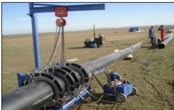
شکل ۶-۵- بستن لوله در گیره‌های دستگاه جوشکاری برای لوله‌های با قطر بالا
