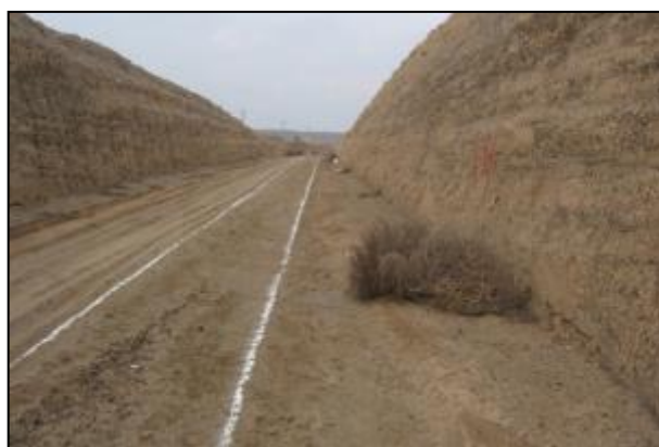
شکل ۶-۱۳- گچ‌ریزی مسیر حفاری خط لوله
