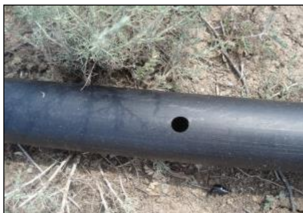
شکل ۶-۱۷- سوراخ‌کاری مانیفولدها برای اتصال لترال
