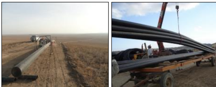
شکل ۶-۳- باراندازی و تخلیه لوله‌های پلی‌اتیلن در طول خط لوله
