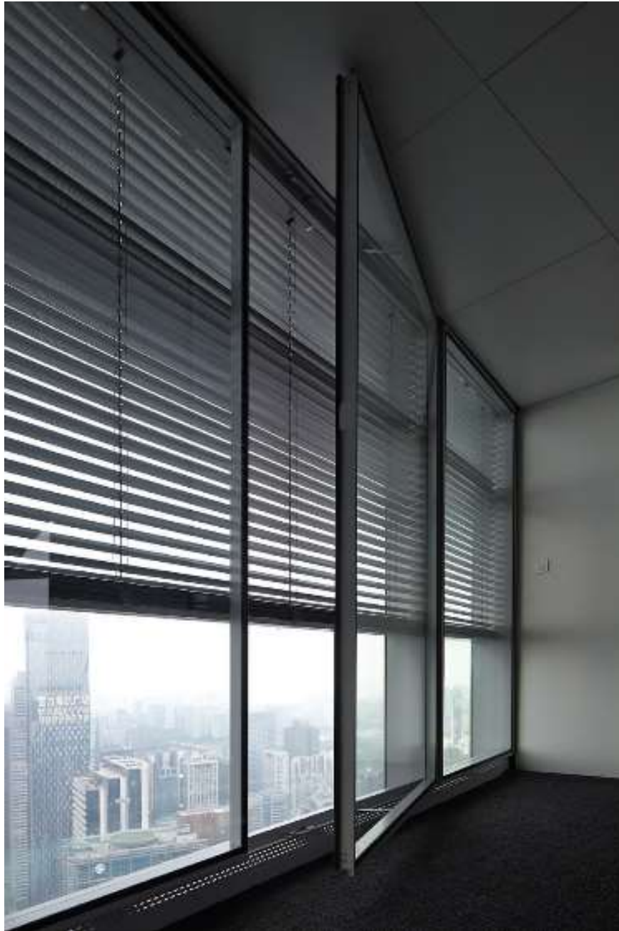
۲۲-۵-۸. پوسته داخلی هر ماژول نمای دوپوسته از دو پانل تک‌جداره تشکیل شده است که برای دسترسی به تعمیر و نگهداری باز می‌شوند. منبع: سیه ژنگ.
