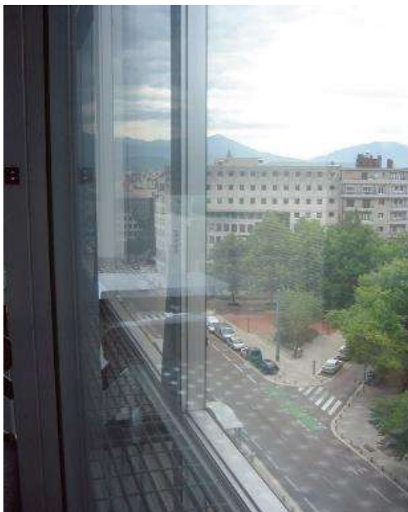
شکل ۸-۲-۱۸. فضای داخلی محفظه: نمای دوپوسته کت واک‌های میله‌ای فلزی جریان هوا بین سطوح را امکان پذیر می‌کند، کرکره‌های قابل تنظیم کنترل موتوری در داخل محفظه و در کنار پوسته داخلی نصب شده‌اند و کنترل‌های کاربر بر روی میل پنجره در هردفتر قرار دارند، منبع: ماری بن بونهام.
