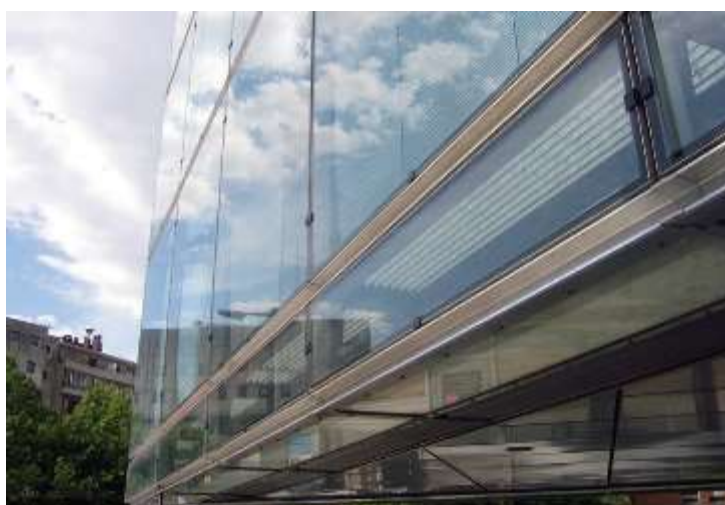
شکل ۸-۲-۱۹. ورودی هوای: نمای دوپوسته هوا از طریق بازشوی افقی از پایه شفت چندطبقه وارد می‌شود، جریان هوا با یک دمپر موتوری در راستای پوسته داخلی کنترل می‌شود، منبع: ماری بن بونهام.
