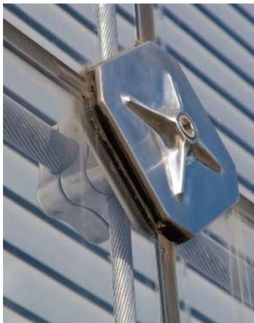
شکل ۳-۲۷. دانشگاه لویولا، صفحه اتصال گیره کابل دوطرفه فولادی ضدزنگ، منبع: مایک پترسون.
