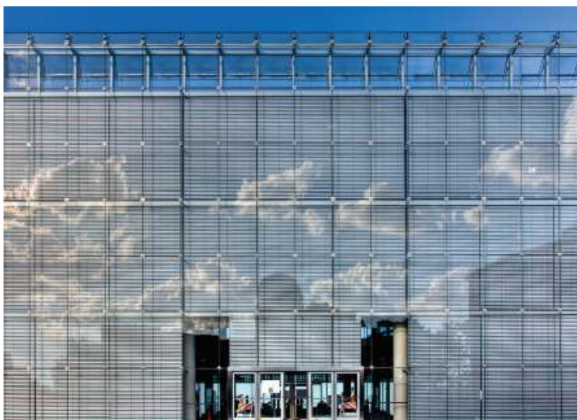
شکل ۳-۲۰. ساختمان اطلاعات عمومی ریچارد جی کلارک، دانشگاه لویولا ۲ ، نمای غربی با شبکه کابلی.
