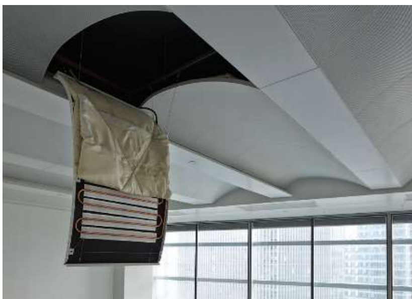
شکل ۸-۵-۱۹. نمای سیستم سقف خنک‌کننده تابشی با یک پنل باز برای آشکار کردن اجزای سیستم، منبع: سیه ژنگ.
