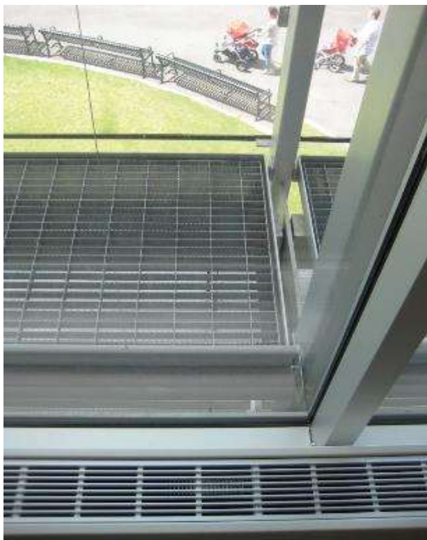
شکل ۸-۳-۲۲. کت واک‌های ۱ رنده فلزی اجازه می‌دهد تا جریان هوا بین سطوح از نمای داخلی طبقه دوم مشاهده شود. منبع: ماری بن بونهام.
