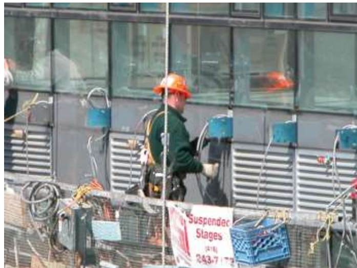
شکل ۷-۱۰. مرکز تحقیقات سلولی و زیست‌پزشکی ترنس دانلی، کارگران ساخت‌وساز روی صفحات معلق کار کردند تا نما را برای نصب پوسته بیرونی آماده کنند. براکت‌های فولادی از پوسته بیرونی و یک راهروی لعبادار در حفره آنان را پشتیبانی می‌کنند. دریچه‌های داخلی نشان داده‌شده هوای حفره‌ای را به واحدهای فن کوئل در پلنوم سقف اداری می‌رسانند، منبع: تری میر بوک.
