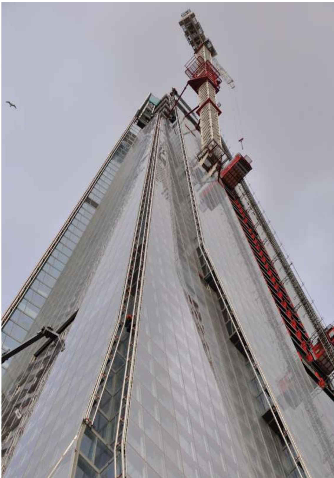
شکل ۷-۱. ساختمان شارد در زمان ساخت، در زمان نصب روکش فلزی در ارتفاعات بالاتر، یک جرثقیل به‌طور موقت در بخش میانی برج ساخته شده، منبع: تری میر بروک.
