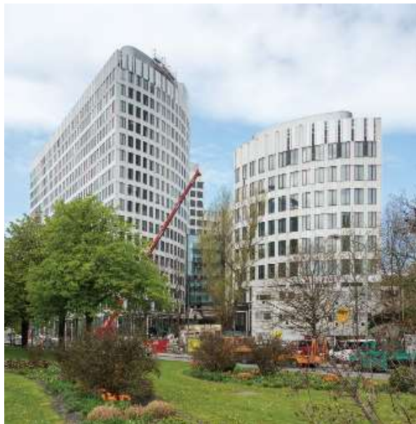
شکل ۳-۲۴. ساختمان لئو ۳ ، اندکی قبل از اتمام آن، آوریل ۲۰۱۳، منبع: اپیزنتروم ۴ .
