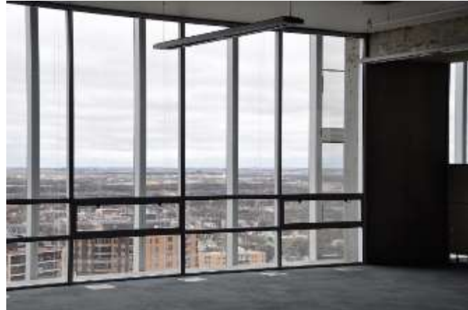
شکل ۸-۴-۱۷. نمای داخلی نمای دوپوسته با کرکره در حالت جمع شده. منبع: تری میر بوکه.
