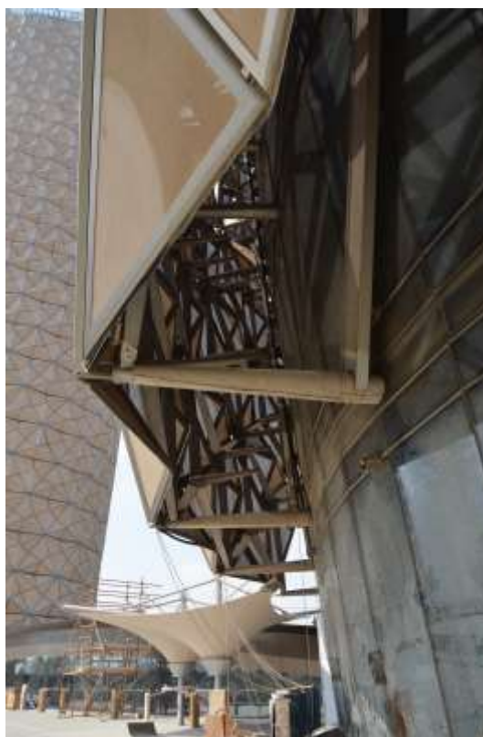
شکل ۶-۱۵. مصالح پی تی اف ایی ۱ با پوشش تفلون در برج آل باهار یک غشاء محافظ کششی و شفاف در برابر نور خورشید و شن و ماسه ایجاد می‌کند، منبع: تری میر بروک.
