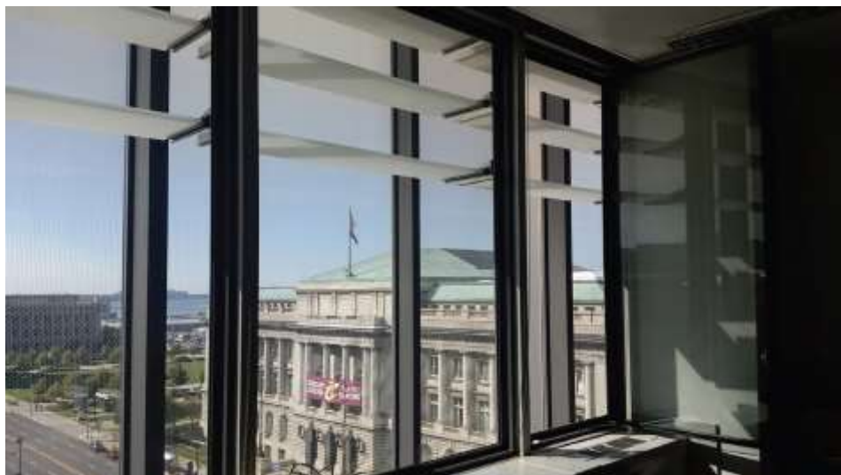
شکل ۵-۱۱. تصویری از نمای راهروی ای جی، ساختمان دفتر فدرال سلبرز، فریت سرامیکی در شیشه بیرونی و نوری که از طرف شبکه‌های شیشه‌ای حکاکی‌شده کنترل می‌شود، پنجره‌ها در پوسته اصلی داخلی فقط برای اهداف تعمیر و نگهداری باز می‌شوند، منبع: ماری بن بونهام.
