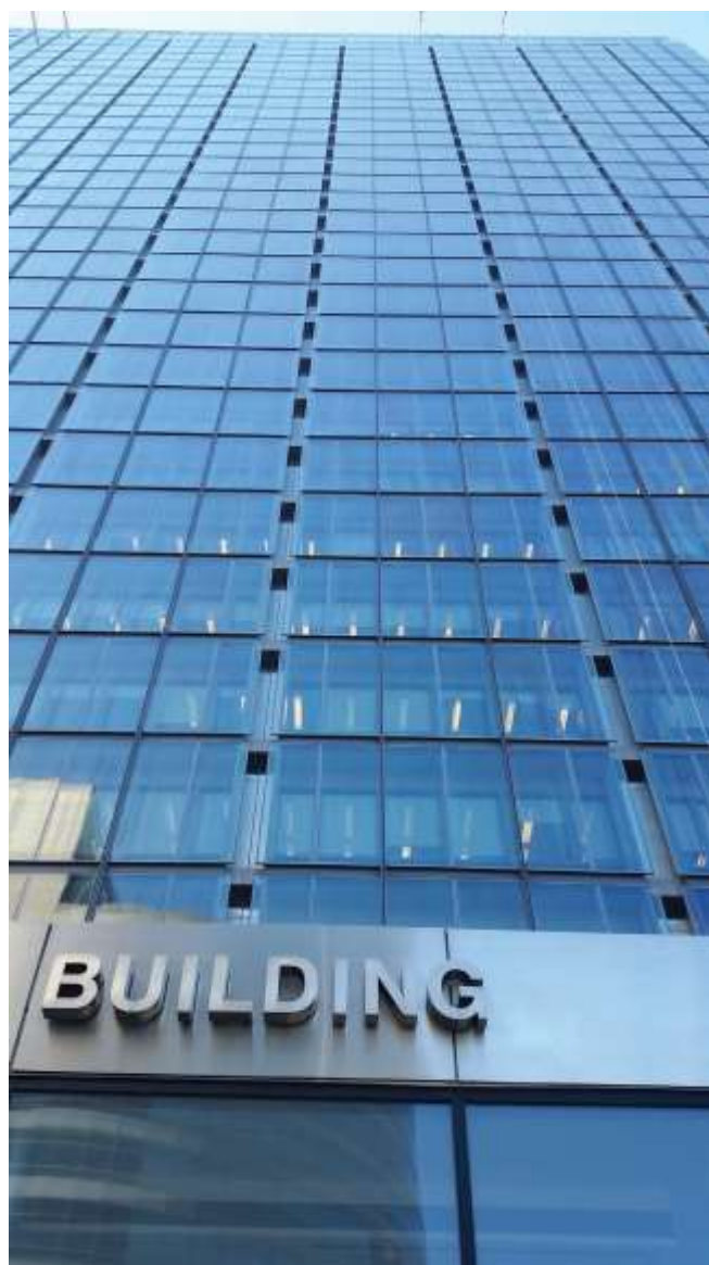
شکل ۵-۹. نمای شمال شرقی ای جی، ساختمان دفتر فدرال سلبرز در کلیولند، اوهایو، نمای اصلی برای تشکیل نمای دوپوسته پنجره جعبه‌ای در نماهای شمال شرقی و شمال غربی روکش شده است، منبع: ماری بن بونهام.
