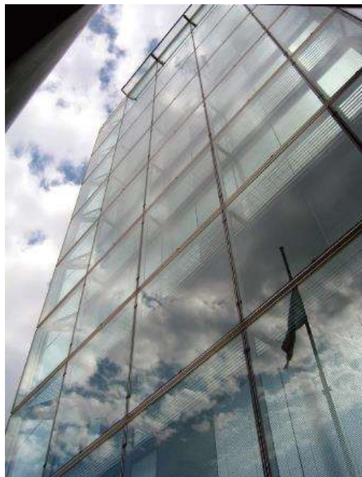
شکل ۸-۲-۱۷. خروجی هوای: نمای دوپوسته پنجره‌های قیف شیشه‌ای با کنترل موتوری، هوای گرم‌شده را از بالای شفت چندطبقه خارج می‌کنند، منبع: ماری بن بونهام.
