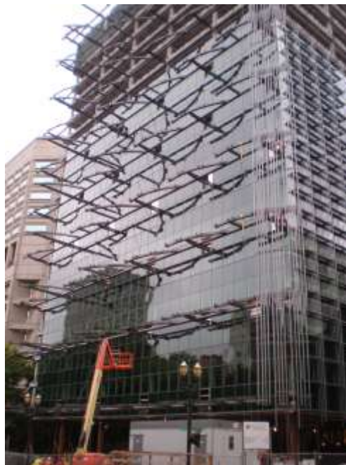
شکل ۶-۱۲. ادیت گرین - ساختمان فدرال وندل وایت (پورتلند، اورگان، ایالات متحده آمریکا)، نمای شیشه‌ای تک‌پسته و روند ساخت دیوار پرده‌ای در سال ۲۰۱۱، منبع: انودر بیلپور ۵ .
