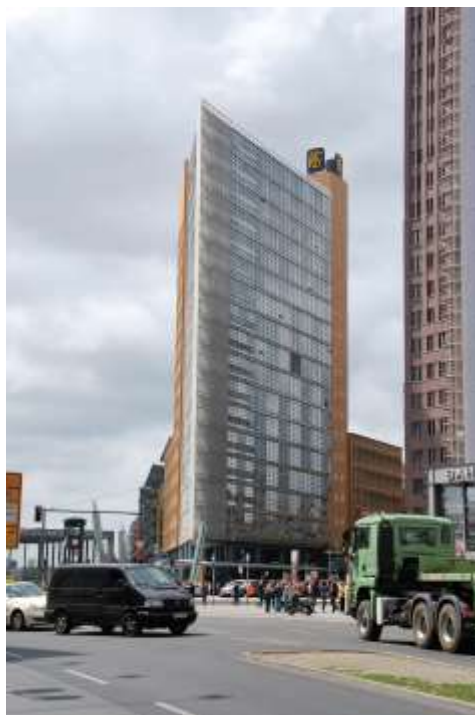
شکل ۵-۵. برج فروم، پوتسدامر پلاتز ۱۱، برلین، آلمان، نمای دوپوسته شیشه‌ای از نظر طراحی بسیار شبیه به برج دبیس است. در اینجا پنجره شیشه‌ای در خط کف با قاب فلزی افقی ارائه شده است و صفحات ثابت شیشه‌ای پوسته بیرونی را تشکیل می‌دهد که در آن ساختمان به یک نقطه مثلی می‌رسد. منبع: تری میر بروک ۳ .
