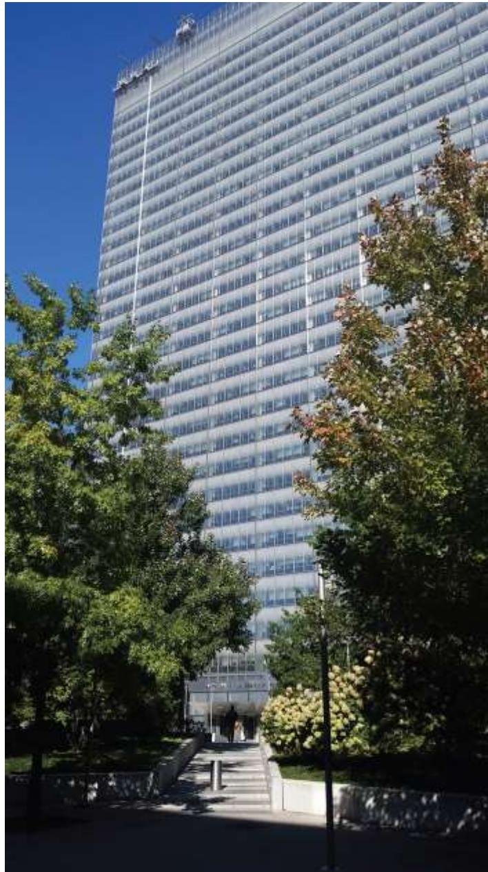
شکل ۵-۱۰. نمای جنوب غربی A.J. ساختمان دفتر فدرال سلبرز در کلیولند، اوهایو، نمای اولیه برای تشکیل یک راهروی نمای دوپوسته در نماهای جنوب غربی و جنوب شرقی روکش شده است، منبع: ماری بن بونهام.
