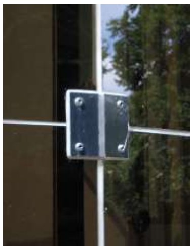
شکل ۴-۱۵. اجزای اجرایی پشتیبان برای نصب شیشه، ساختمان فابر و دوما، عکس از اندرو دان ۶ ، گرفته‌شده در آگوست سال ۲۰۰۵.
