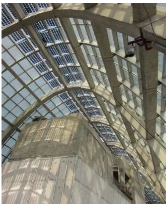
شکل ۸-۵-۲۶. نمای شیشه‌های فتوولتائیک از داخل تاج دوطبقه برج، منبع: اس او ام.
