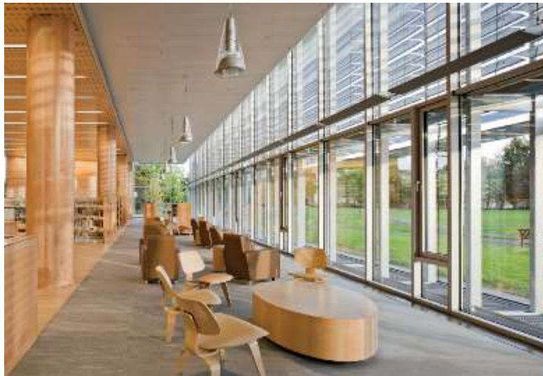
شکل ۸-۳-۱۷. اتاق مطالعه در طبقه همکف با آسمان کمی ابری: در این نما، کرکره‌های قابل تنظیم در موقعیت افقی قرار دارند. سطوح کرکره نور روز را به سقف داخلی هدایت می‌کنند. منبع نور پراکنده مکمل، نور مستقیم بعد از ظهر با زاویه پایین را که وارد فضای زیر آفتاب‌گیر شیشه‌ای می‌شود متعادل می‌کند. منبع: عکاسی رابرت بنسون ۲ .
