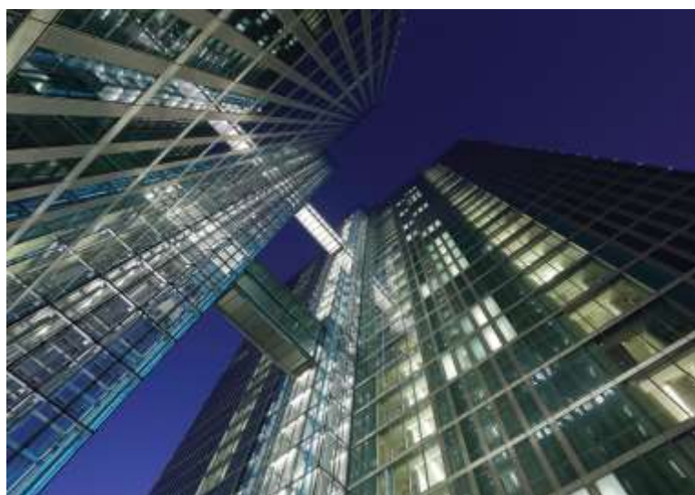
شکل ۶-۷. نگاهی به نمای تک‌پوستی برج‌های های‌لایت بیزینس، پنجره‌های باریک قابل اجرا مجهز به پانل‌های فولادی ضدزنگ سوراخ‌دار با پانل‌های سه‌جداره ثابت عریض‌تر جایگزین می‌شوند، منبع: مارتین فالبیزونر ۳ .
