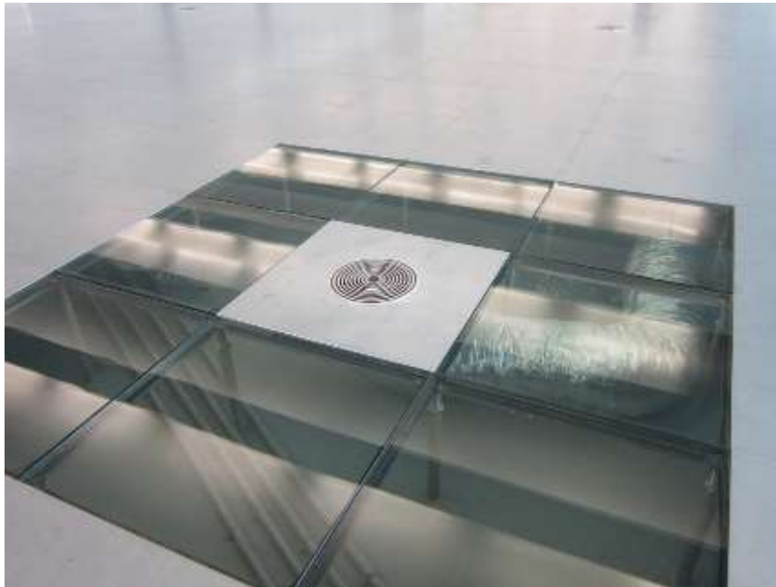
شکل ۸-۵-۲۰. یک «پنجره حقیقی» ۱ در سیستم طبقه مرتفع در دفتر اجاره پی آر تی، انتقال هوای تهویه کانالی و استفاده از این پلنوم را برای توزیع انعطاف‌پذیر سایر سیستم‌ها نشان می‌دهد. منبع: ماری بن یونهام.
