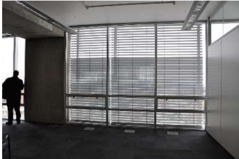
شکل ۸-۴-۱۶. نمای داخلی نمای دوپوسته با کرکره‌های پایین، قسمت بالایی کرکره‌ها در حالت افقی قرار می‌گیرد و به عنوان قفسه‌های سبک عمل می‌کنند. منبع: تری میر بوکه.
