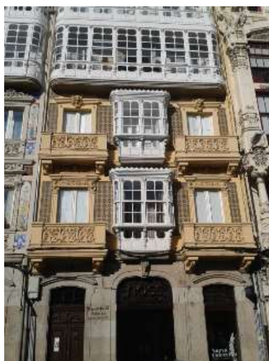
شکل ۴-۹. ساختمان‌های مجهز به گالری در بندر لاکرونیا ۳ در گالی سیاه، اسپانیا، منبع: گئورگس ۴ .
