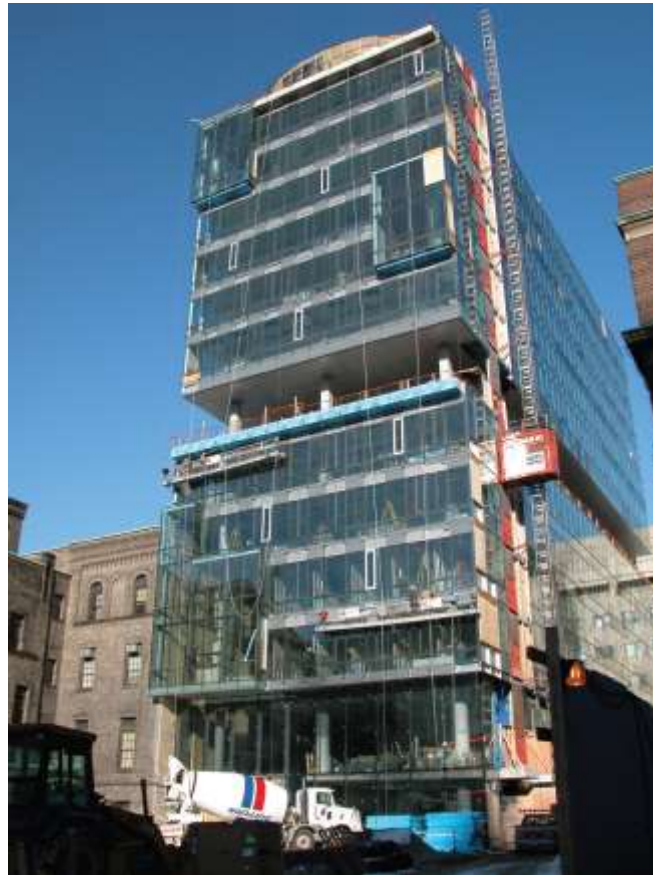
شکل ۷-۹. مرکز تحقیقات سلولی و زیست‌پزشکی ترنس دانلی (تورنتو، کانادا، ۲۰۰۶). ساخت نمای دوپوسته با نصب پوسته داخلی آغاز شد، یک دیوار پرده با شیشه چندجداره در یک قاب آلومینیومی با شکست حرارتی، بخش‌هایی از نما که به‌صورت تک‌پوسته باقی می‌مانند، مانند دهلیز، ۱ متر جلوتر قرار می‌گیرند. منبع: تری میر بوک.
