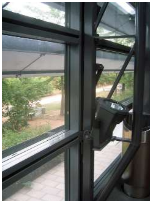
شکل ۸-۲-۲۲. ماژول‌های پنجره واحد دارای شکاف‌های نفوذپذیر بخار، بین پوسته‌های لعاب‌دار عایق‌بندی‌شده هستند. منبع: ماری بن بونهام.
