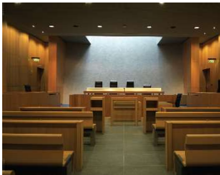
شکل ۸-۲-۱۴. سطح اصلی دیوار دادگاه، نورگیری با فرم کج و مقعر دارد که با بافت گچ به‌رنگ خاکستری روشن برای توزیع نور ایجاد شده است، منبع: فیلیپ رالت با مجوز از معماران واسکونی توسط توماس اسپینکو.
