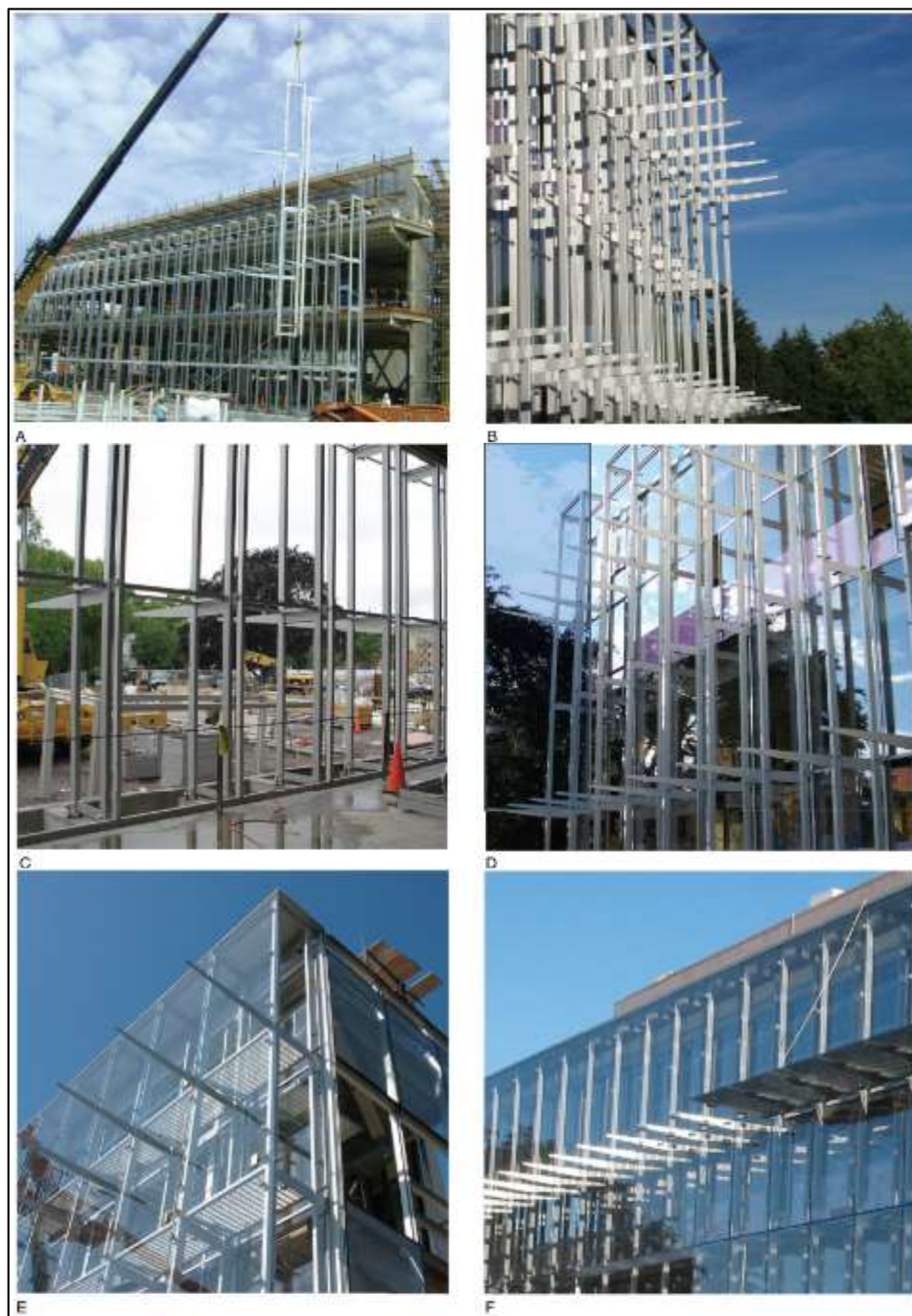
شکل ۸-۳-۲۰. توالی ساخت نمای دوپوسته: (A) نصب قاب نردبان سازه، (B) قاب نردبان سازه، (C) قاب دیوار تیغه‌ای داخلی نصب‌شده، (D) نصب لعاب دیوار تیغه‌ای داخلی در حال انجام است، (E) نصب دیوار تیغه‌ای بیرونی در حال انجام است، (F) نصب گیره شیشه‌ای در حال انجام است. منبع: همکاران معماران، شرکت ویلیام راون.
