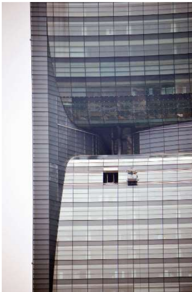
شکل ۸-۵-۲۴. نمای جنوبی برج رودخانه مروارید، روزنه‌های توربین بادی بین دو سطح مکانیکی قرار دارند. یکی از تجهیزات تعمیر و نگهداری نما محل قرارگیری دهانه‌های نما با پانل در حالت باز جمع شده دیده می‌شود. منبع: تری میر بواکه.
