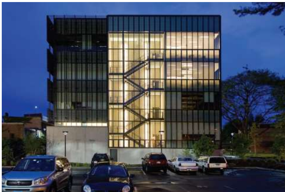
شکل ۳-۶. نمای تک‌پوسته با شیشه سه‌جداره، اسپندل آئروژل و صفحه آفتاب‌گیر خارجی،
