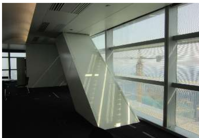
شکل ۸-۵-۱۴. نمایی از نمای شرقی سه‌جداره با ساختار مهاربندی متقاطع ساختمان در پیش‌زمینه، منبع: ماری بن بونهام.
