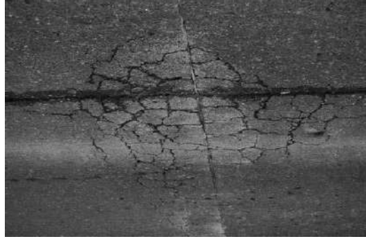
شکل ۵-۵: نمونه ای از ترک موزائیکی.
