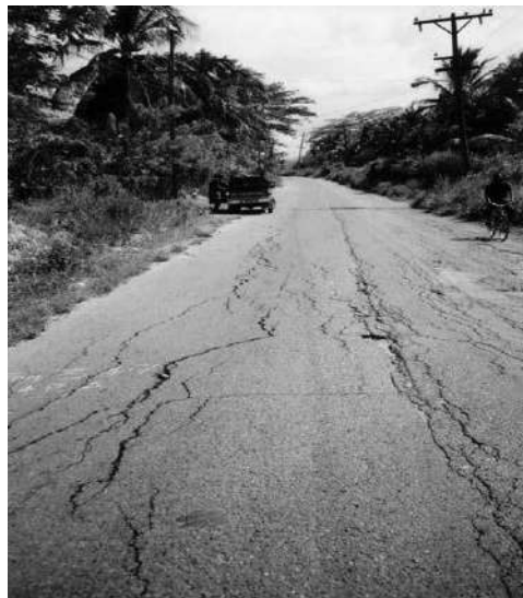
شکل ۵-۶: نمونه ای از ترک طولی (با کسب اجازه از نیگل هویت)
