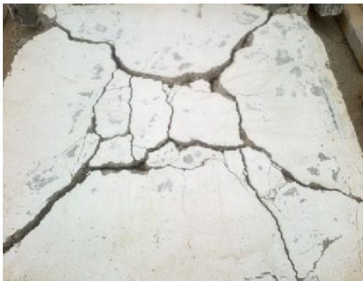
شکل ۴- گسیختگی دال بتنی در لحظه‌ی نهایی بارگذاری
