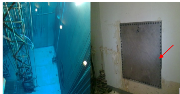
شکل ۲. دریچه های موجود روی دیوار شرقی استخر
