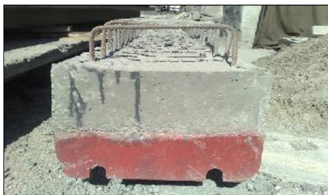
شکل ۳- بتن‌ریزی اولیه تیر نیمه پیش ساخته
