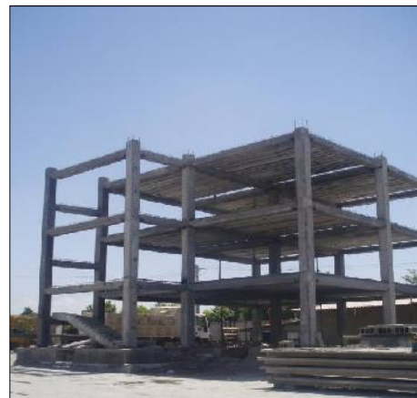
شکل ۱- نمایی از ساختمان در حال اجرا با سیستم نیمه پیش ساخته
