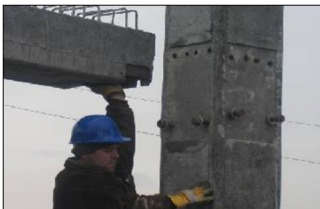
شکل ۴- نحوه‌ی اتصال تیر نیمه پیش ساخته به ستون
