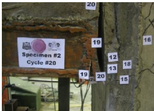
شکل ۱۲- نحوه خرابی قطعه اتصال اولیه در آزمایشگاه
