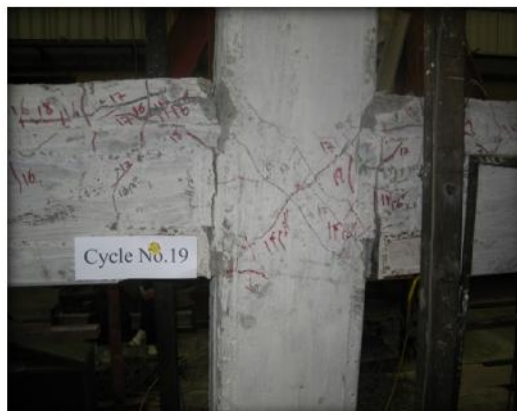
شکل ۱۰- ضعف در قطعه اتصال و جدا شدن تیرها از ستون سازه
