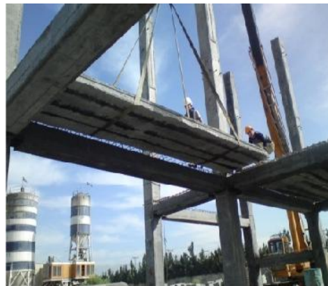
شکل ۶- نصب دال پیش ساخته مجوف پیش تنیده
